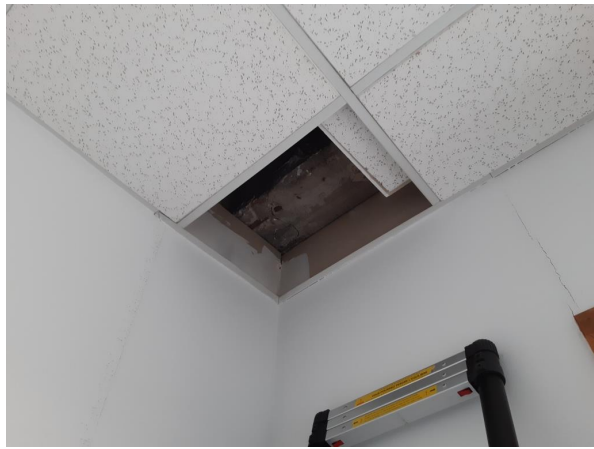
Prélèvement - P014 : Aile Rue POIREL / Etage 3 / Bureau 8 - Bande de plaque de plâtre- (Absence d'amiante)
