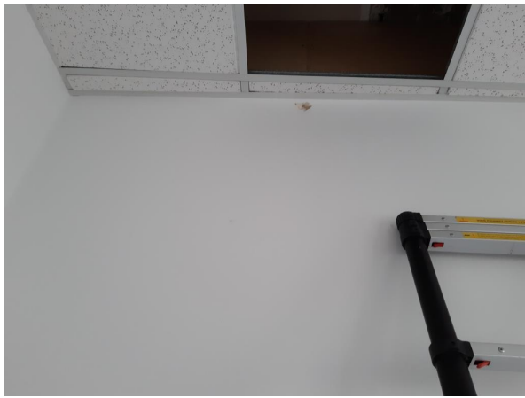
Prélèvement - P007 : Aile Rue POIREL / Etage 3 / Bureau 3 - Bande calicot- (Absence d'amiante)
