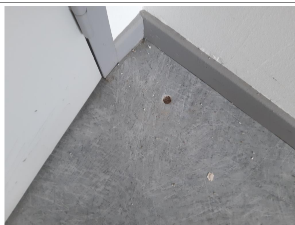
Prélèvement - P006 : Aile Rue POIREL / Etage 3 / Bureau 3 - Dalle de sol- (Absence d'amiante)
