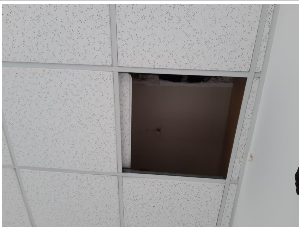
Prélèvement - P009 : Aile Rue POIREL / Etage 3 / Bureau 3 - Enduit lissé- (Absence d'amiante)
