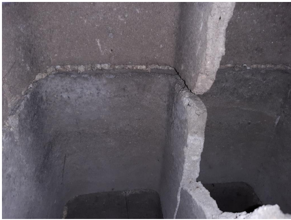
Prélèvement - P020 : Aile Rue POIREL / Etage 3 / Bureau 7 - Coffrage perdu- (Absence d'amiante)
