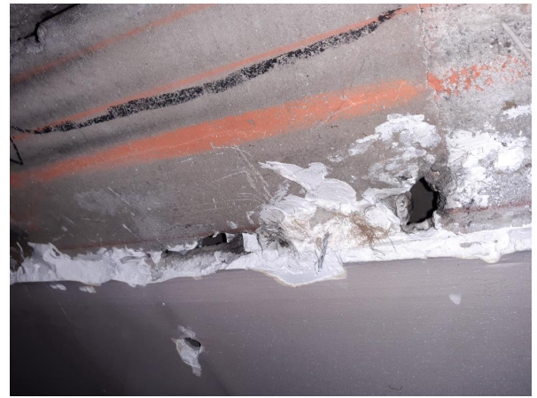
Prélèvement - P021 : Aile Rue POIREL / Etage 3 / Bureau 7 - Enduit lissé- (Absence d'amiante)
